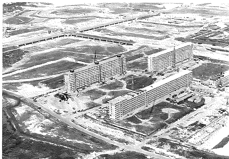
56 De afdeling Bruggen van de Dienst Publieke Werken had tot taak viaducten te maken waar ook tanks over konden rijden. Wat er later onder moest komen moesten anderen maar weer uitzoeken. De flats in deel A in aanbouw. De viaducten, op de plaats waar nu het hoofdwinkelcentrum gebouwd is, liggen er al.
