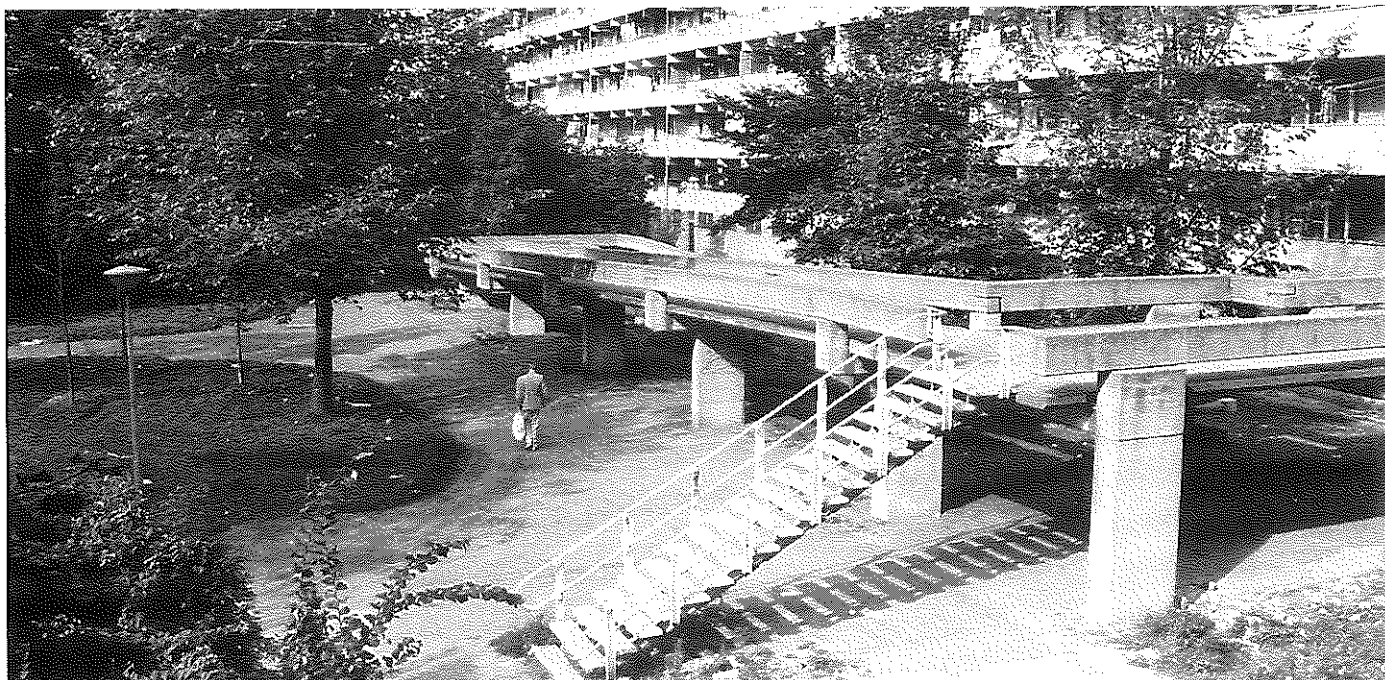
55 Om in de binnenstraat te kunnen komen werden 'hellingbanen' aangebracht.
