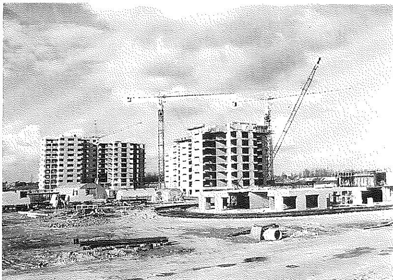
57 De flats van de Amsterdamse architect J. van Stigt: Gouden Leeuw en Groenhoven, in aanbouw in februari 1974.
